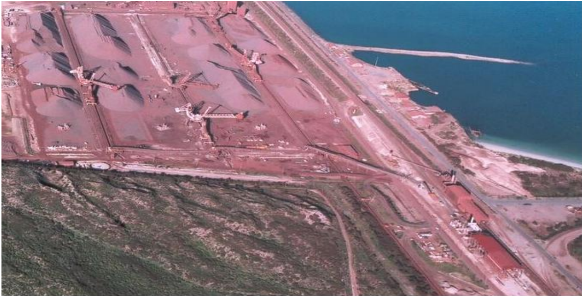
Figure 7.10 Entrepôts typiques avec bâtiments Colombophilie et bacs empileurs/récupérateurs
