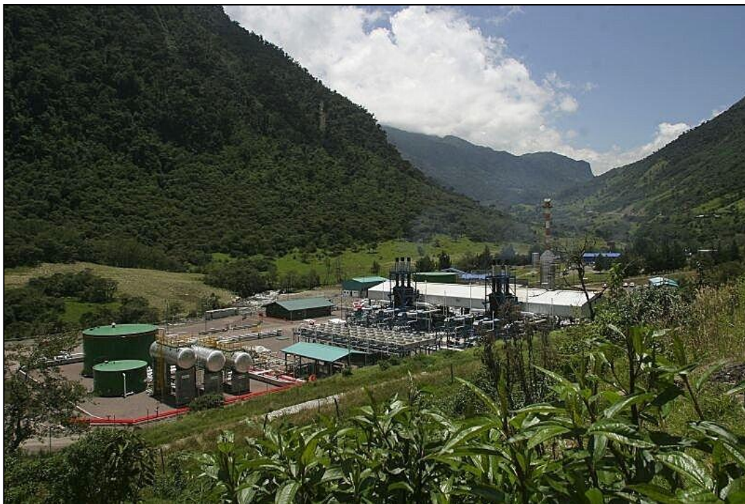
Figure 9.1 Une centrale Electrique typique de HFO
