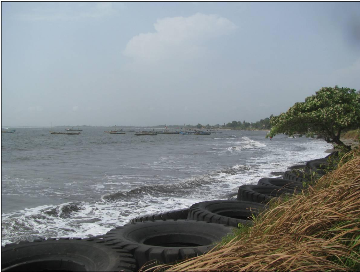
Figure 12.17 Protection des plages le long de la côte de Buchanan (source : personnel de BSGR Guinée)
