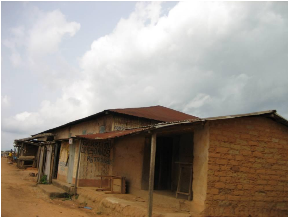
Figure 12.11 Une partie du village de Zogota (Source: DWA)
