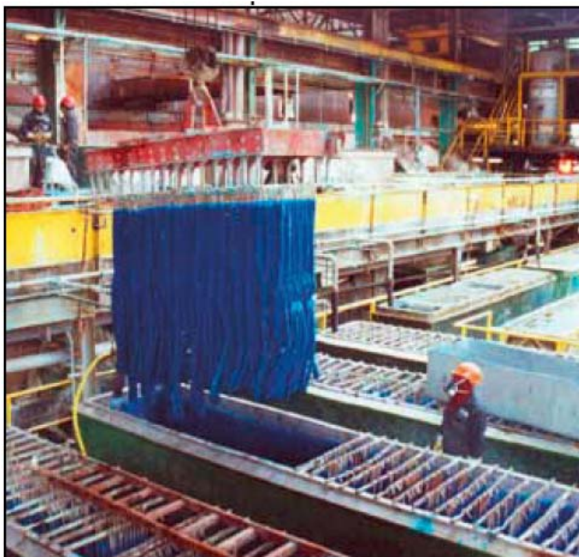
Planta de Tratamiento de Licor Madre
